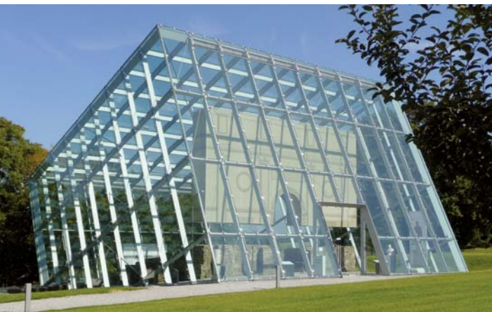
3 Schutzhaus Limestor Dalkingen
