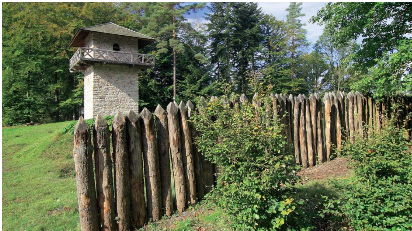
▶ Limesrekonstruktion mit Wachturm, Graben/Wall und Holzpalisade
